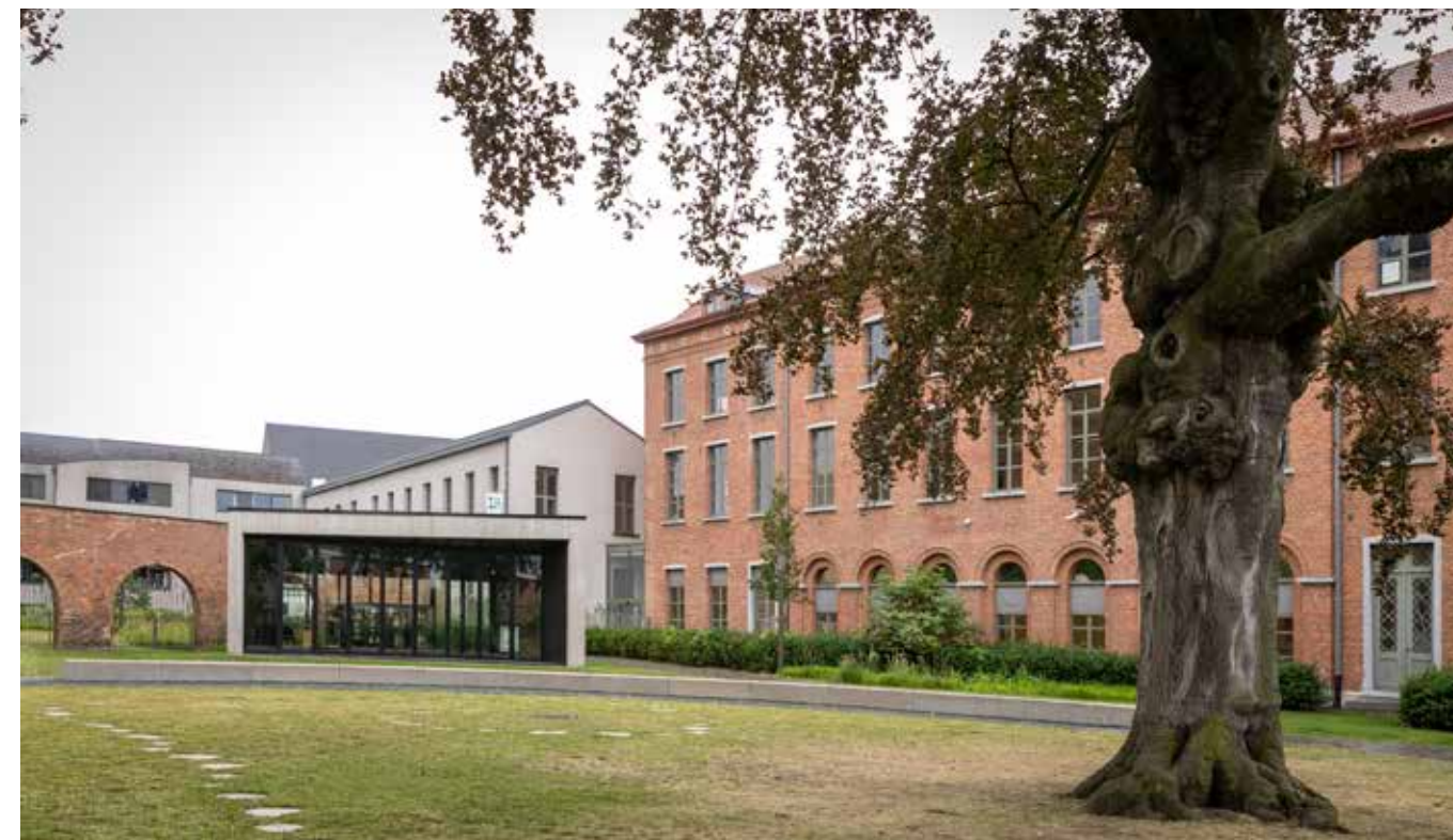
ETAP verving alle noodverlichtingsarmaturen in het OPZ in Geel en ondersteunt hen in het onderhoud gedurende twintig jaar.
